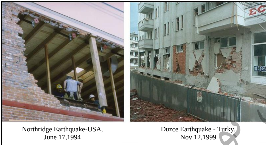
شکل ۹-۱- تخریب خارج از صفحه میانقاب‌های بنایی غیرمسلح در زلزله‌های نورتریج و دووژه
